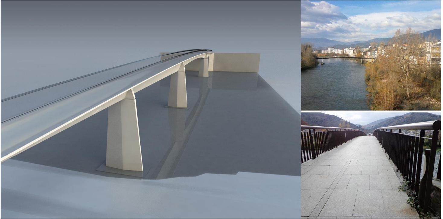
La estructura es una pasarela peatonal compuesto por un tablero de 4 vanos, con luces de 20,00 + 25,00 + 48,50 + 21,50 m entre ejes. La longitud total es de 115,00 m. La anchura constante del tablero es de 3,00 m.
